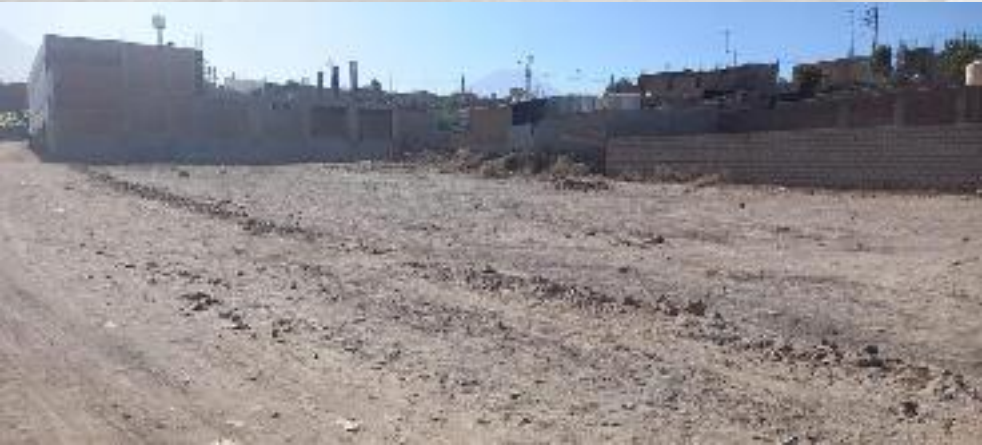
VISTA PANORÁMICA DEL PROYECTO
