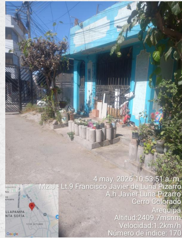
Img. 12- Después de la intervención
