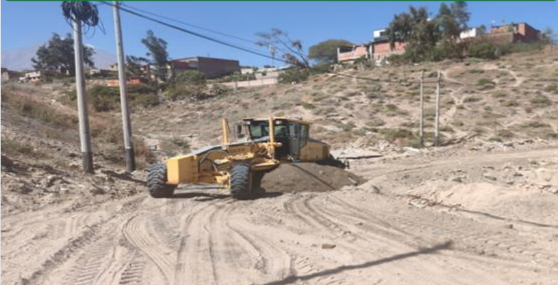
REHABILITACION DE PASE ENTRE CERRO COLORADO Y CAYMA (AV. 54)
